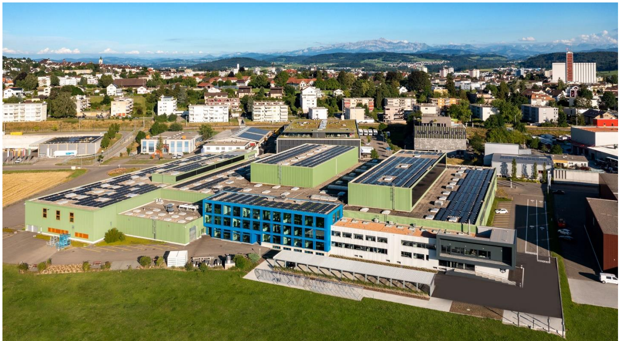
Abbildung 2 Dach der SCHMOBI mit Photovoltaikanlage (Bild SCHMOLZ + BICKENBACH Stahlcenter AG)
